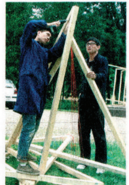
Mit Balken und Spanplatten arbeiten die Künstler. RÖNNAU
